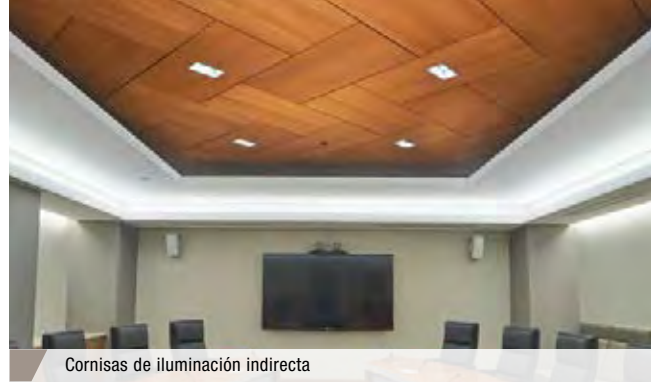
Cornisas de iluminación indirecta
