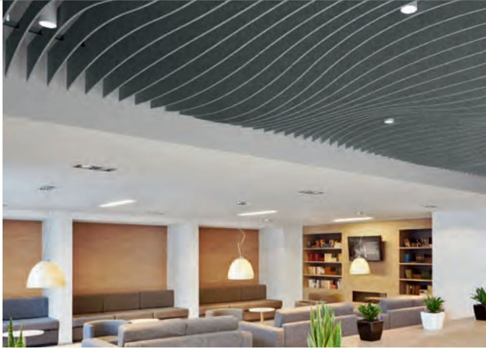
▲ Instalación con gancho del kit FeltWorks® Blades Ebbs & Flows con separación de 4" entre las placas
