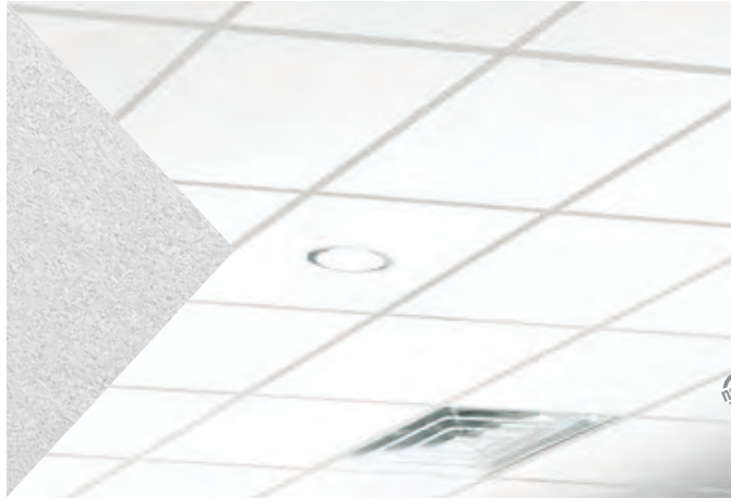
▲ Plafones Calla® con alto NRC de orilla cuadrada con sistema de suspensión Prelude® XL® de 15/16"
