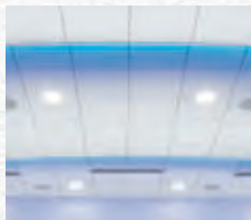
8 Cornisas de iluminación
