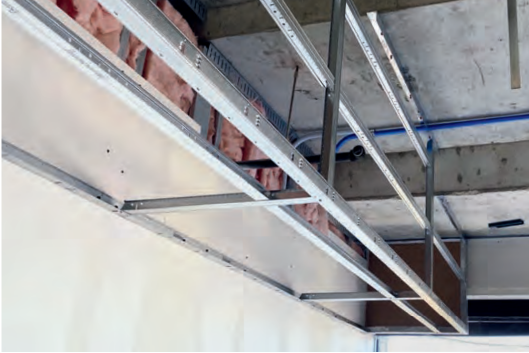
▲ Sistema de entramado de cajillos para paneles de yeso Simple Soffit™
